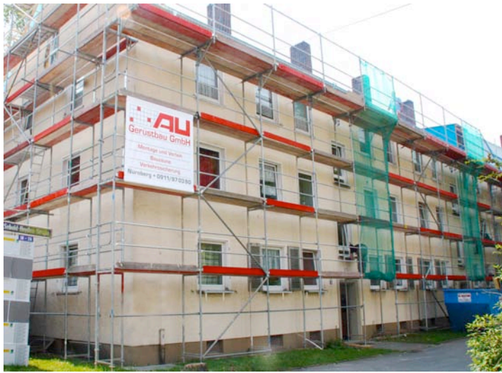
(Bild: VH/MJ-Gerüst GmbH) Sanierung einer Wohnsiedlung im Großraum Nürnberg.
